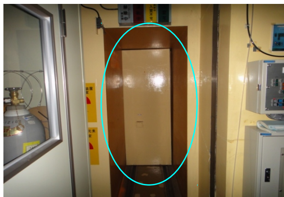
扉の傾斜により閉まらない
