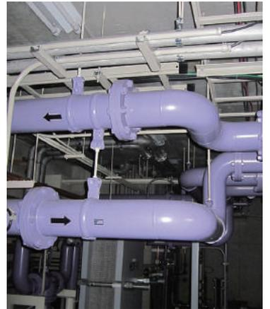
冷却水配管。発熱した装置を冷やすために冷却水をポンプで循環させている。冷却水の種類や行き先などを区別するために色とりどりの配管が張り巡らされている。
