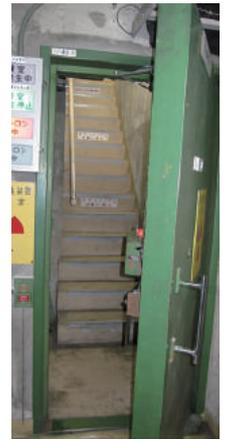
施設内の廊下や扉。制御用の信号や電磁石コイルに電流を供給するケーブルも敷かれている。ビーム照射中に放射線が外に漏れないように、場所に応じて適切な厚さの扉が設置されている。最も厚いコンクリート製の扉は4mにもなる。
