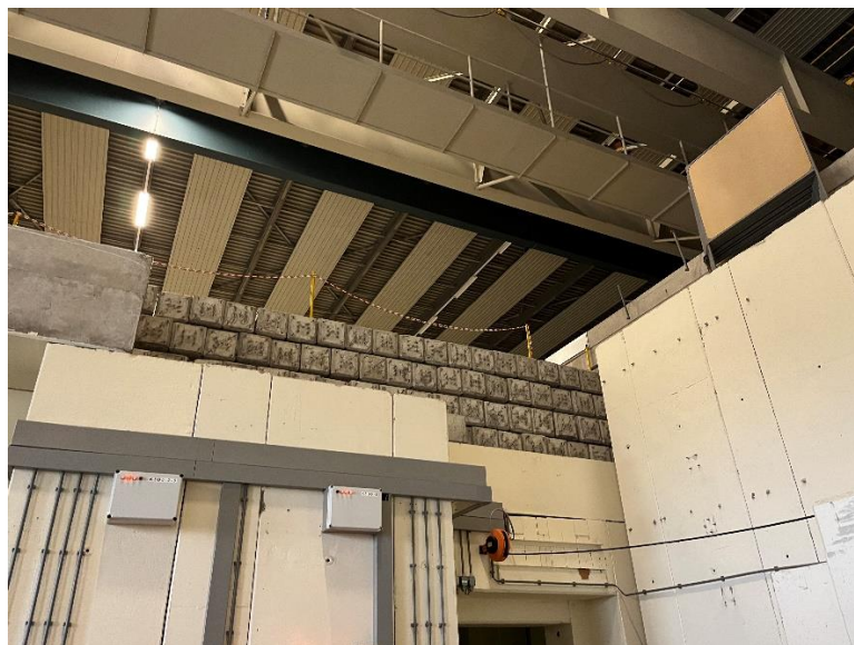
(図 3) 実験室の天井の様子
